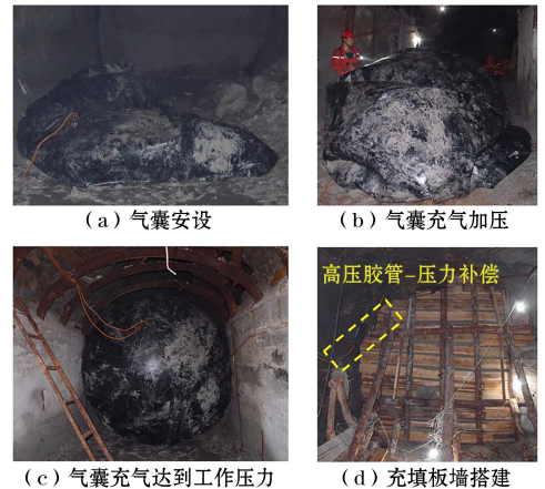
图 9 采场预占位隔离充填气囊现场安置过程及效果
